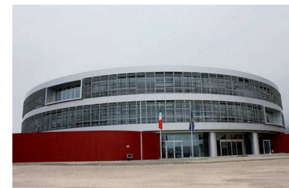
Nuova sede del Compartimento ANAS dell'Aquila, dotata di isolamento sismico
